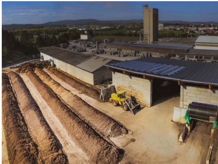
Рисунок 1.10 – Компостування у відкритих укріплених буртах (джерело: https://www.compost-systems.com/en/solutions/open-paved-windrow-composting )
