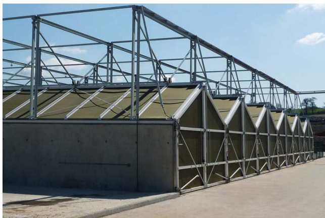
Рисунок 1.4 – Установка для компостування в рядах (буртах) з покриттям металевими листами
